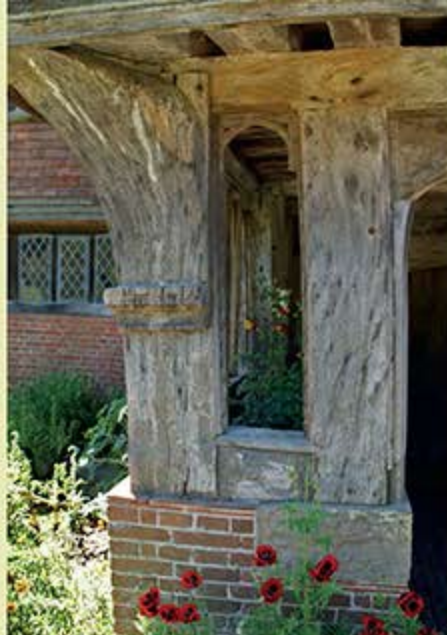
Oben: Alte Balken stützen das Dach ab
